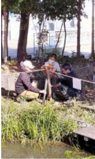
トンボ池の杭とロープの補修
